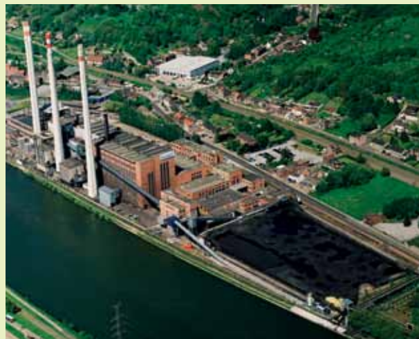
Centrale avant 2005, avec parc à charbon
