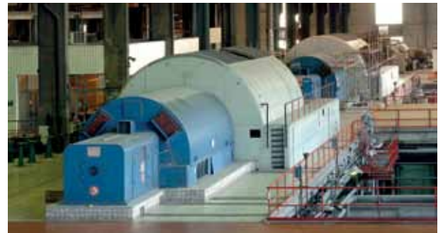
Salle des machines – Turbo-alternateurs
