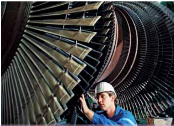
Révision de la turbine à vapeur
